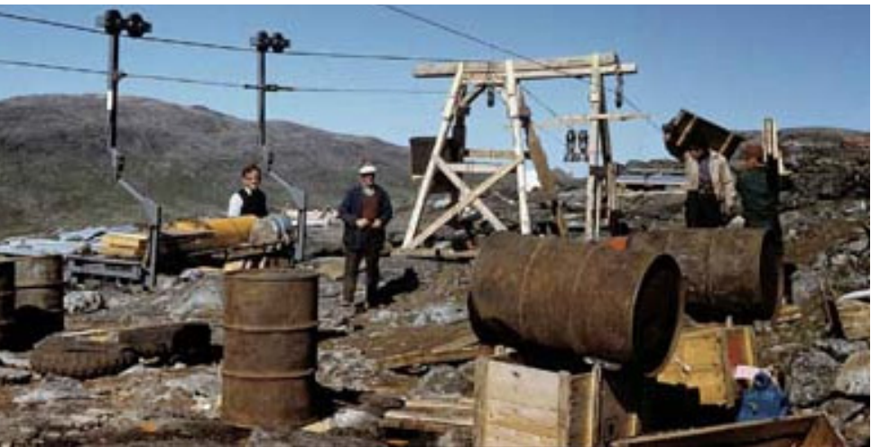
Uranefter søgning førte i to omgange til forsøgsminedrift på Kvaneffjeld i Sydgrønland i perioderne 1958-62 og 1978-81. Til kampagnen i 1958 blev der etableret en tovbane til transport af materiel og brudt malm.
